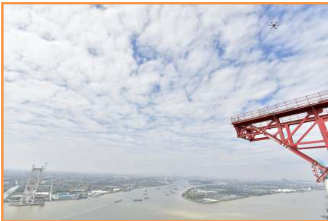
无人机正在牵引过渡索。
