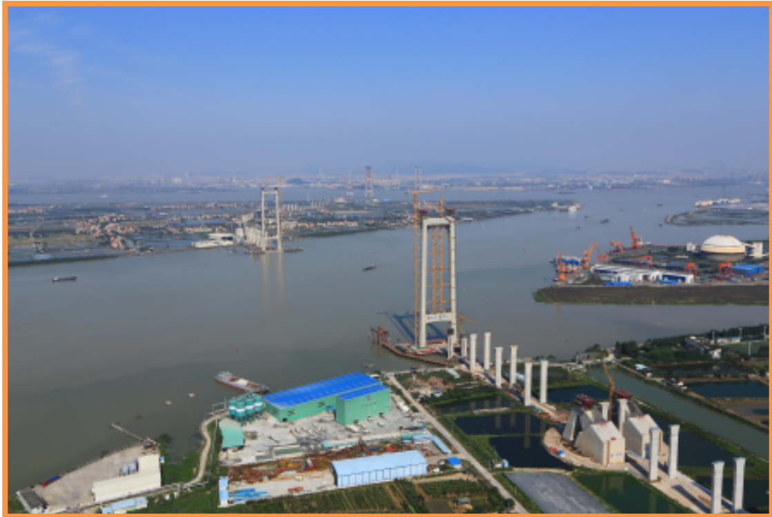
虎门二桥施工现场。
