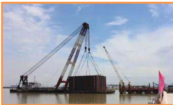
建设中的洪奇沥特大桥。
